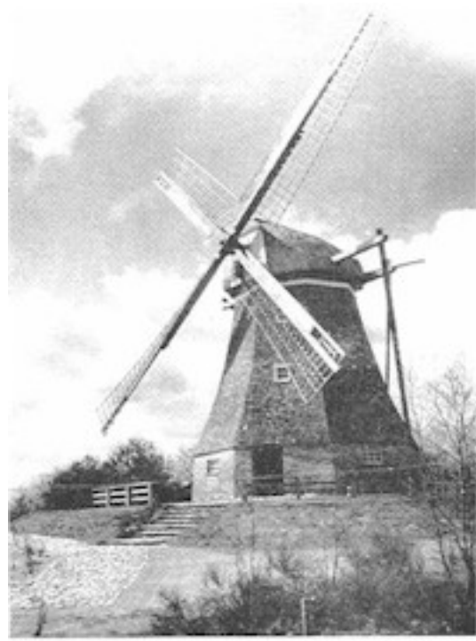
Die Hilter Mühle: nach ihrer Renovierung
