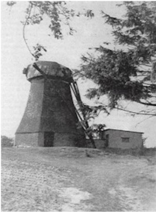
Die Hilter Mühle: vor ihrer Renovierung
